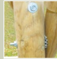
Verbindung mit Schlossschrauben und Holzkrallen
